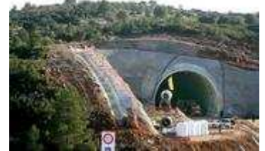
+ Una imatge del túnel a la boca nord, a tocar d'on acaba la via de TP Ferro. Foto: MANEL LLADÓ
