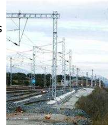
S'acaba la línia construïda del TAV, esquerra separa les obres que ha a es que Adif ha començat al terme d o: JOAN SABATER
