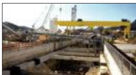
3. Pozo de ataque para la tuneladora de Montcada, que horadará el túnel bajo esta ciudad, hasta alcanzar una profundidad de 55 metros.
