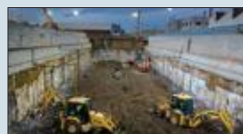
5. Pozo de ataque de la tuneladora que horadará el túnel de la ciudad de Girona, situado en la zona de Mas Xirgu.
