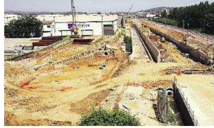
Les obres del Mas Xirgu, on hi haurà la boca del túnel van ser les primeres a començar. aniol resclosa
