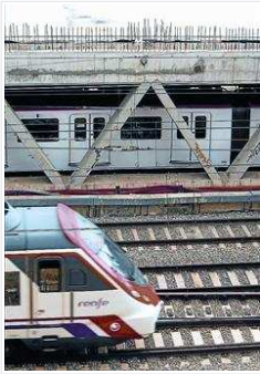
El calaix de formigó que cobreix les vies de la L-1 del metro a Sants a l'altura de la Riera de Tena, divendres. Foto: ALBERT BERTRAN
