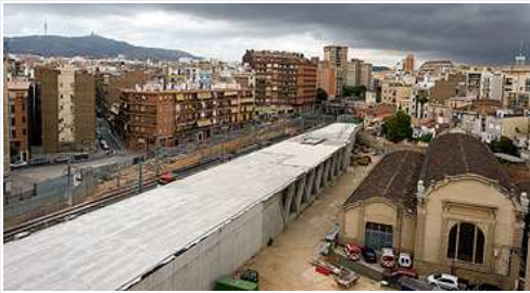
La caixa de formigó que cobreix les vies de la L-1 del metro a Sants a l'altura de la Riera de Tena, divendres. Foto: ALBERT BERTRAN
