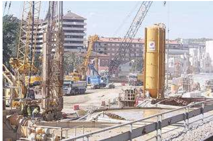
La "zona zero" de les obres de l'alta velocitat a Girona, al parc Central. marc martí
