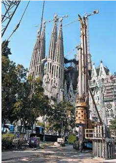
Excavació d'un pilar de prova, ahir. Foto: CAMILA DE MAFFEI
