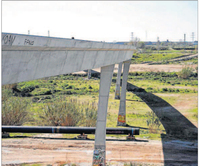
El riu Llobregat, a la seva desembocadura, durant les obres que es van fer per l'arribada de l'AVE. ARXIU
