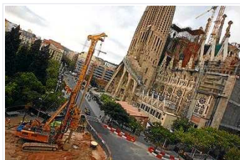
33 Perforació de dos nous pilons a Mallorca-Sardanya, dissabte. Foto: ELISENDA PONS
