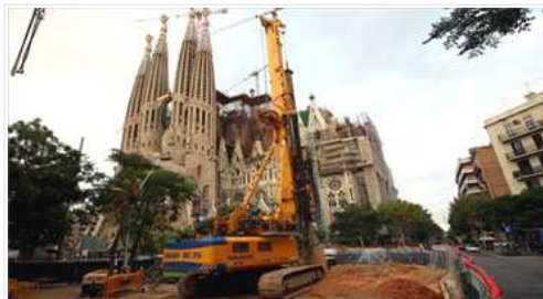
Perforació de dos nous puntals del mur de l'AVE davant de la Sagrada Família. Foto: ELISENDA PONS
