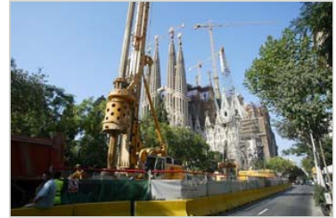
Imatge de les màquines que fan les pilones de protecció al costat de la Sagrada Família. Foto: ( ANDREU PUIG.
